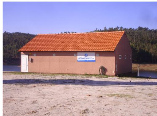
O edifício datado de 2008, serve de apoio à plataforma de embarcações existente actualmente. Construído em apainelados de madeira e cobertura em telha regional de cor vermelha. Devido à
