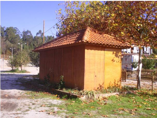
As pequenas construções evidenciadas acima, também em estrutura de madeira, embora assentes numa laje de alvenaria de bloco de cimento, são meramente sazonais e servem de arrumos a pequenos equipamentos de recreio e lazer.
